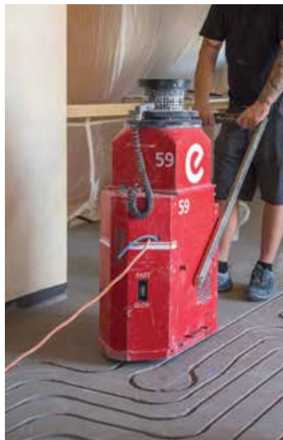
Fresatura su pavimentazione preesistente
