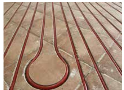
Fresatura su pavimentazione preesistente
