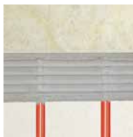
Copertura con piastrella
